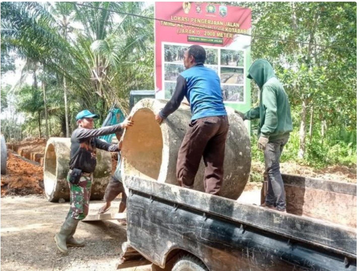
KOTABARU - Mencegah terjadinya genangan air di drainase yang telah di buat oleh satgas TMMMD Ke 116 Kodim 1004/Kotabaru, hari ini satgas mendatangkan gorong-gorong.(30/05/2023)
